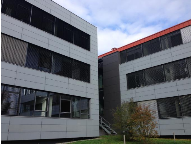
Abbildung 3: Gebäude des Zukunftskollegs
